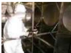
排水設備内の清掃
