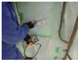
汚染調査作業(2)
