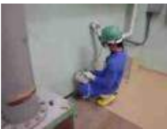
汚染調査作業(1)
